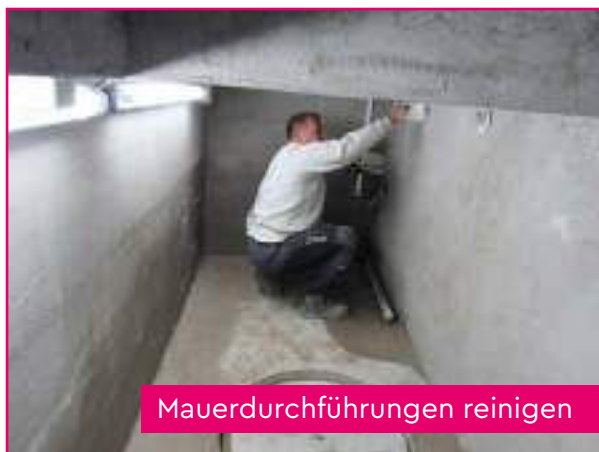
Fittinge reinigen vor Ankleben an Mauerdurchführungen
