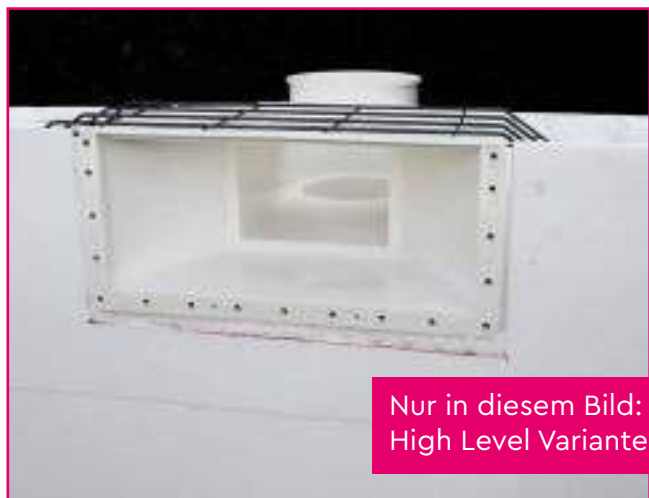
Einbauteile abkleben
