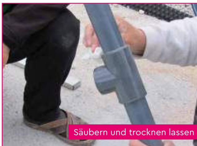
Fittinge zusammenkleben
