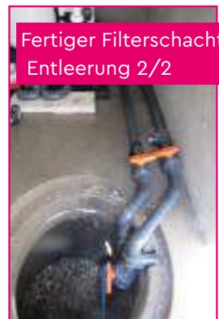
Fertiger Filterschacht mit Entleerung 1/2
