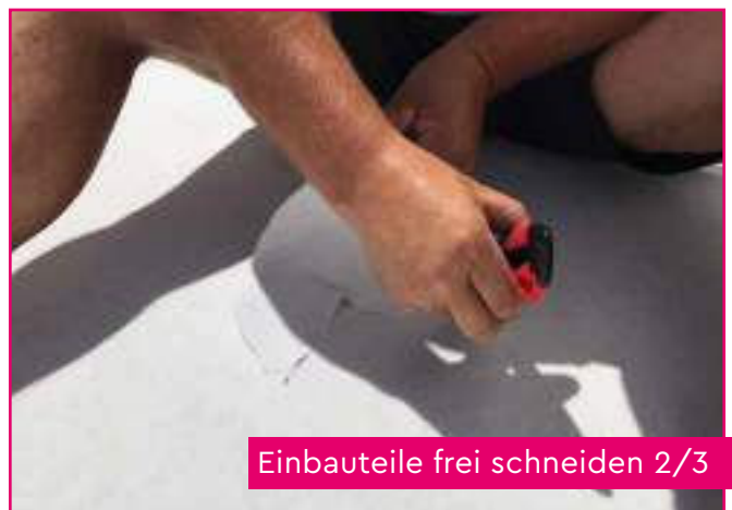
Einbauteile frei schneiden 1/3
