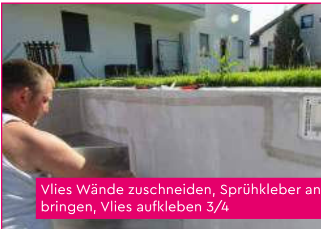
Vlies Wände zuschneiden, Sprühkleber anbringen, Vlies aufkleben 1/4
