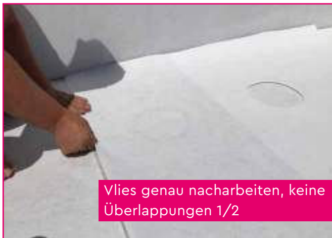
Einbauteile frei schneiden 3/3
