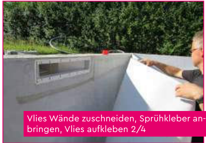
Vlies Wände zuschneiden, Sprühkleber anbringen, Vlies aufkleben 1/4
