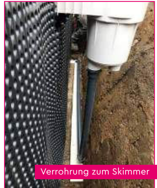
Noppenfolie an Außenseite und Verrohrung über Längsseite
