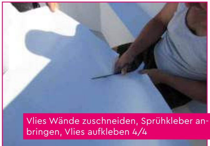
Vlies Wände zuschneiden, Sprühkleber anbringen, Vlies aufkleben 3/4
