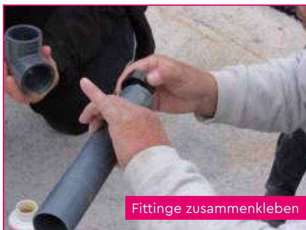
Kleber mit Pinsel auftragen
